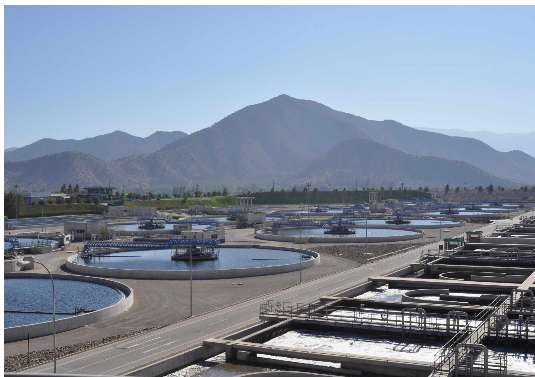
La Farfana WWTP
