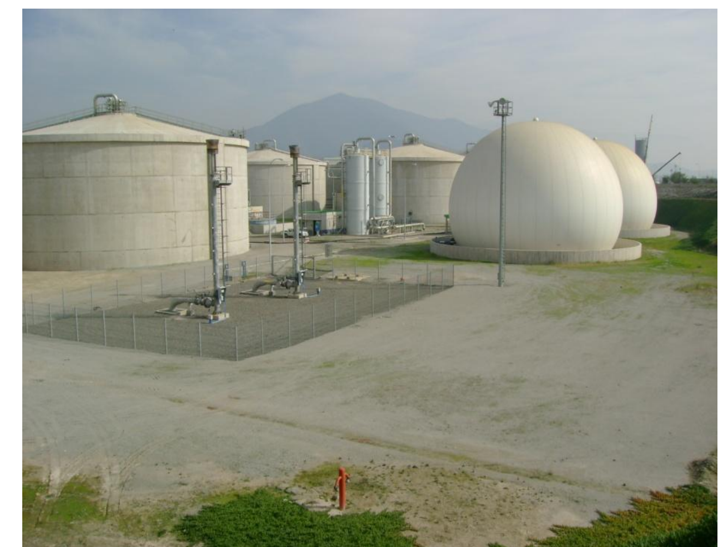
La Farfana WWTP
