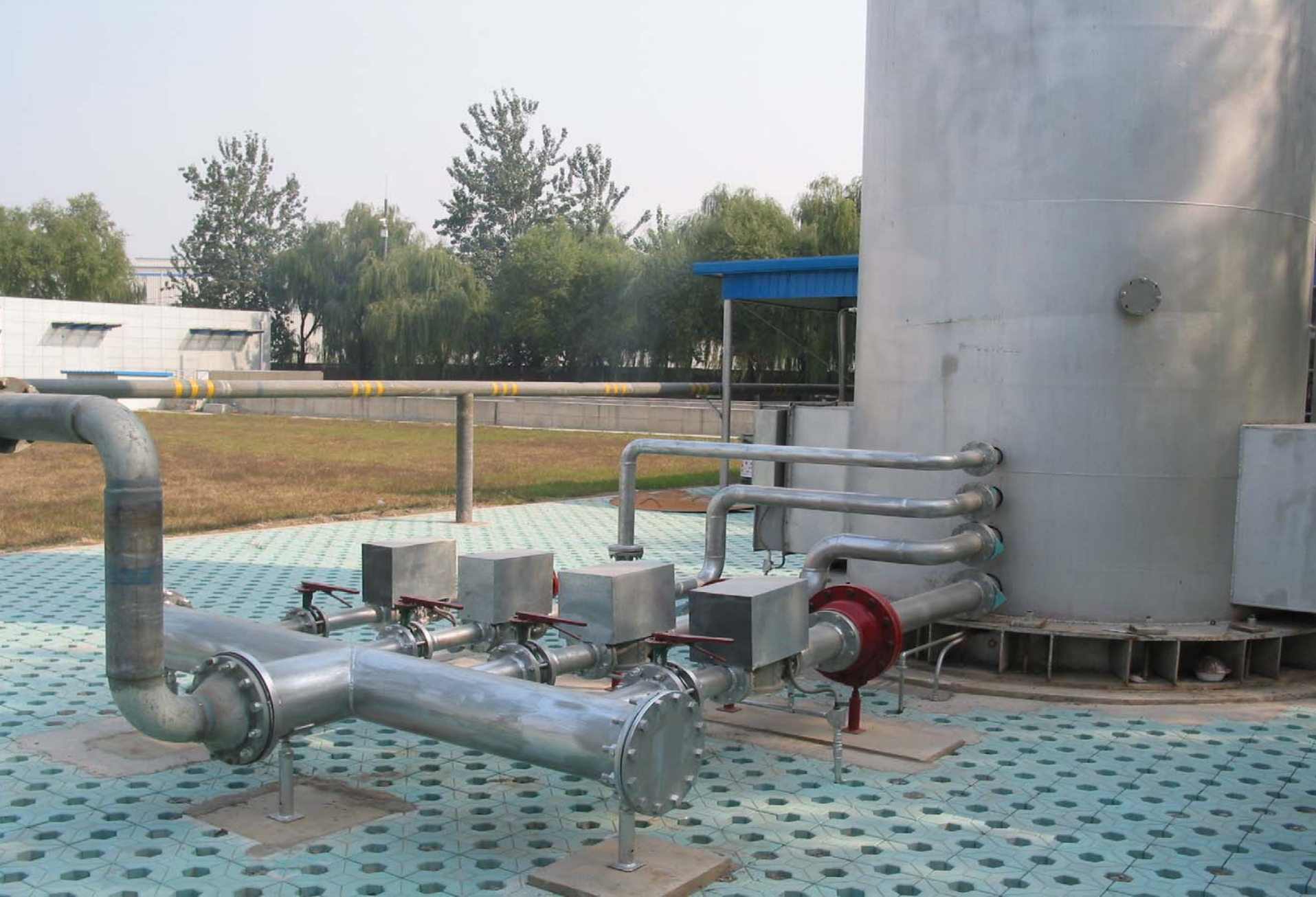
进气分配系统和填埋气火炬
