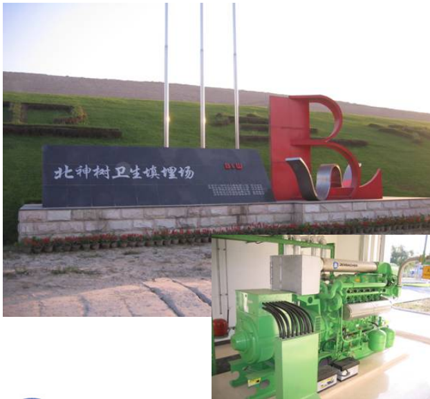
Bei Shen Shu LF/China 1 x JGS 212 GS-S.L 526 kWel
