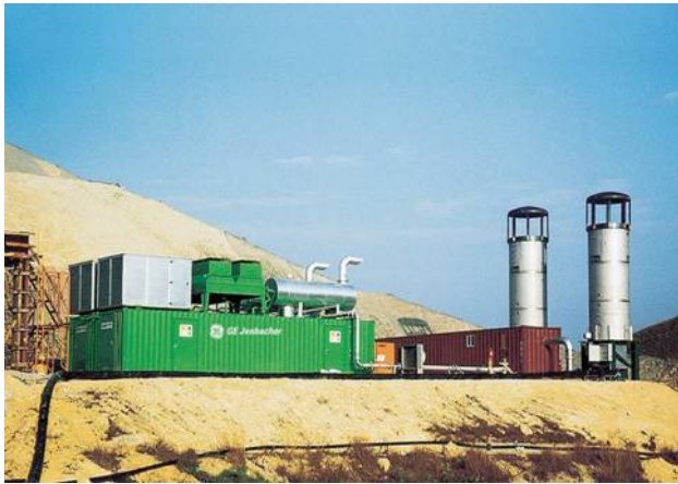
Xing Feng LF/China 2 x JGS 320 GS-S.L 2,130 kWel
