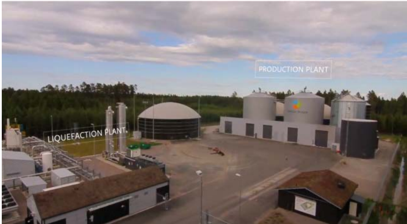
Lidköping Sweden – Biogas to LNG System
