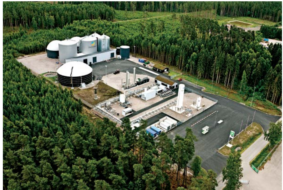
Lidköping Sweden – Biogas to LNG System
