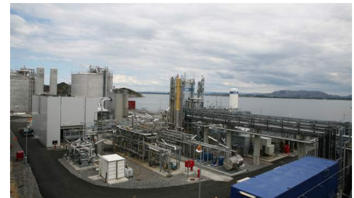
Kollsnes II LNG Plant, Norway (84,000 TPA)
