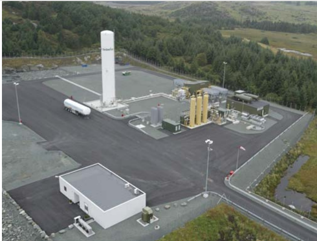
Snurrevarden LNG Plant, Norway (22,000 TPA)
