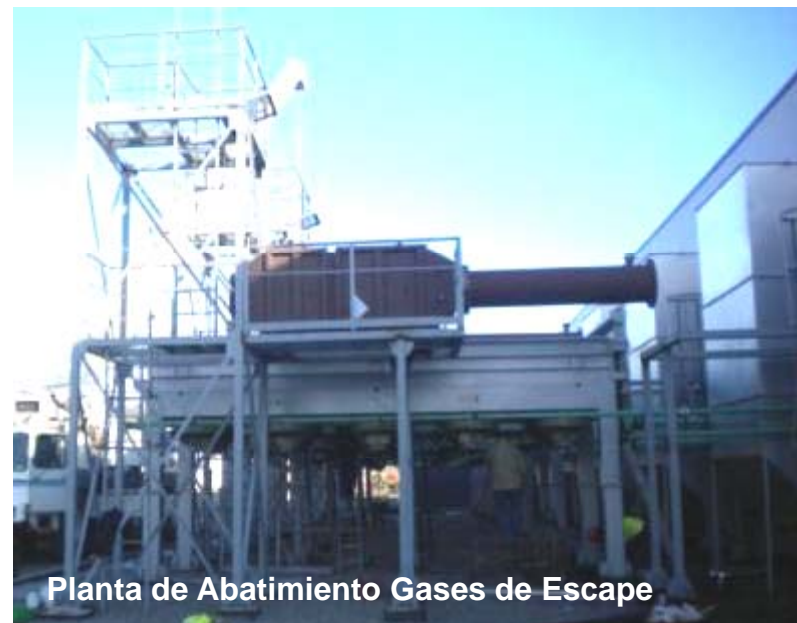
Estado de Avance 21-05-2011
