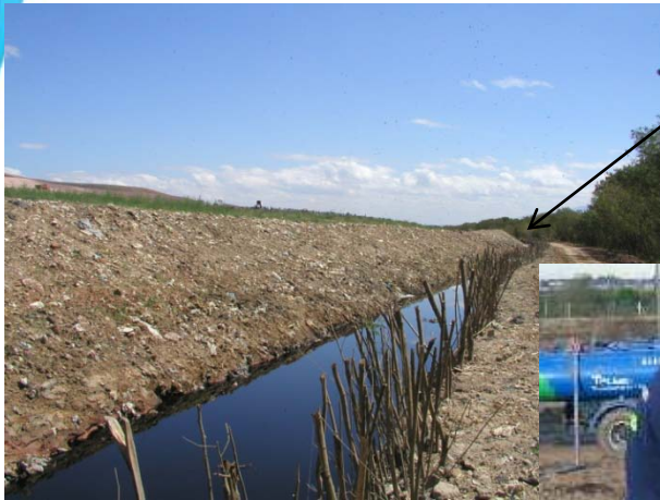
Extracción por gravedad
