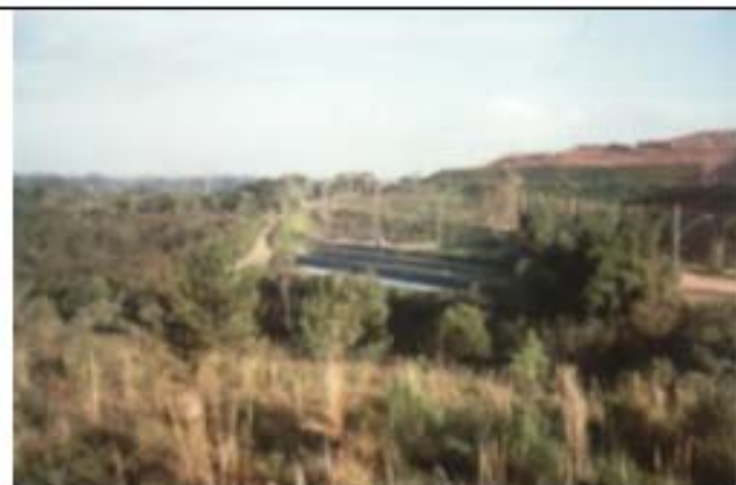
Foto 1. Área lateral do aterro de Gravataí.
