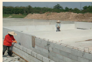
Construction d'un digesteur à la ferme Phanus Amporn, en Thaïlande
