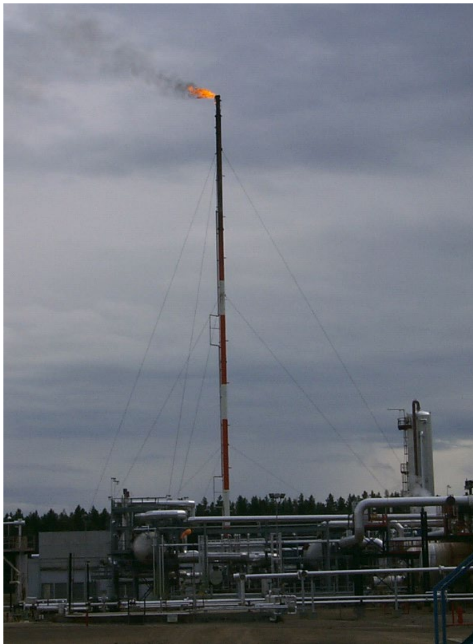
Рисунок 9: Фотография типичного факела на нефтедобывающем объекте.
